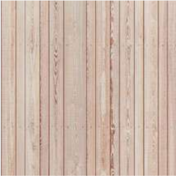
Holzfassade Natur Holzfassade Lattung vertikal geschraubt, Lärche sägerau , natur
