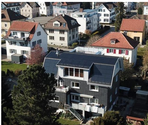
Abbildung 9: Indach PV-Anlage für Beispiel verschiedener Wirkleistungsbegrenzungen
